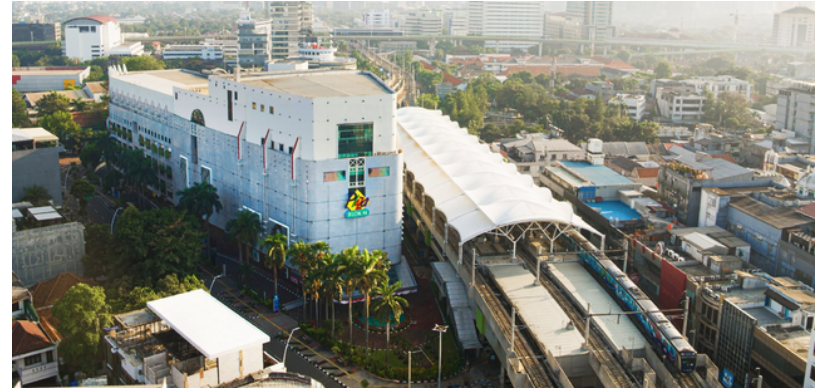
Picture 2.27 Blok M Plaza Source: plazablokm
