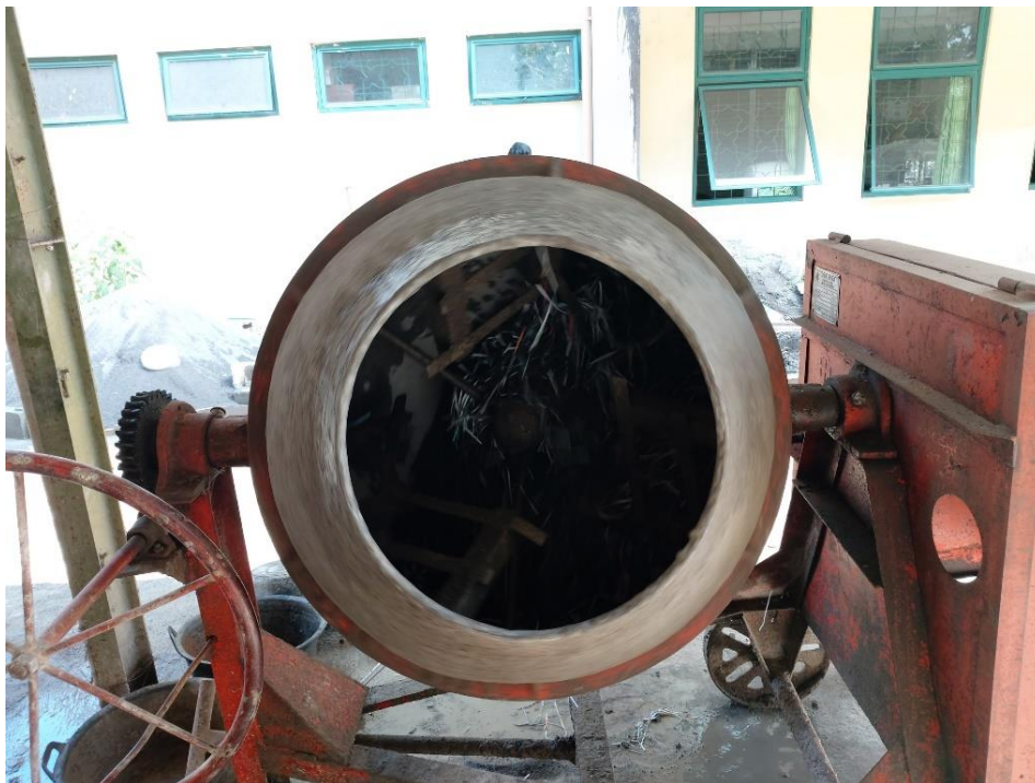
Gambar L-10.8 Proses Pembuatan Campuran Beton
