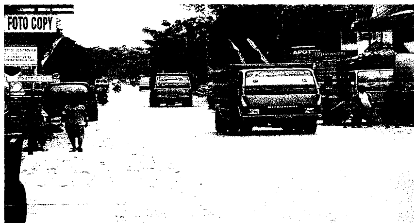
Gambar 5.32 Situasi Daerah Rawan Lokasi 6
