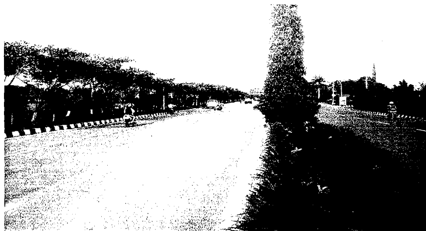
Gambar 5.43 Situasi Daerah Rawan lokasi 3
