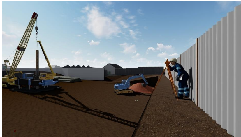
Gambar 5.14 Marking Titik Pemancangan (Pemodelan)
