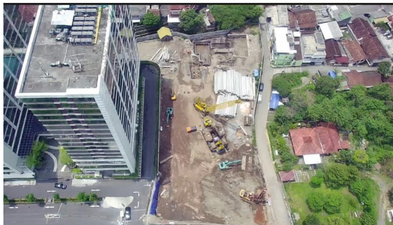
Gambar 5.5 Kondisi Lapangan Tampak Sisi Barat
