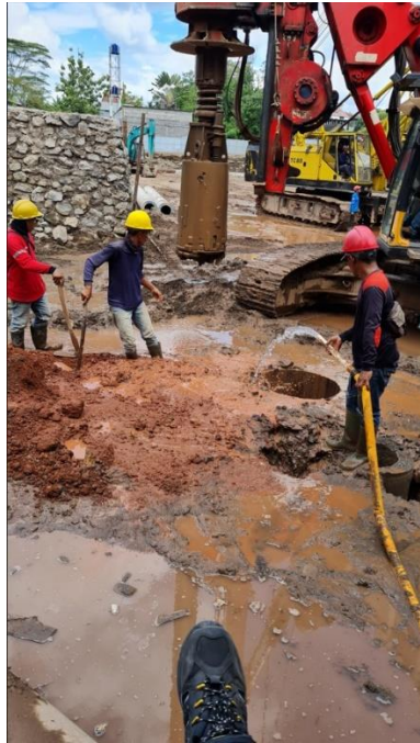
Gambar 5.15 Pengeboran dan Pencampuran Tanah Merah (Lapangan)
