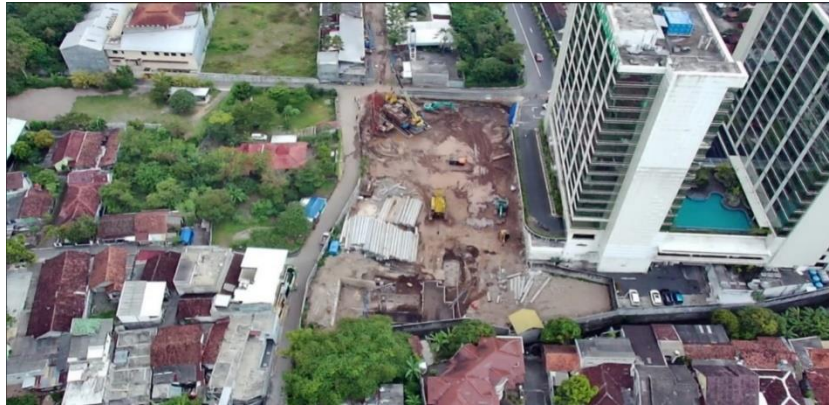
Gambar 5.6 Kondisi Lapangan Tampak Sisi Timur
