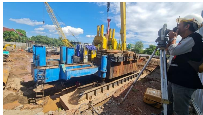
Gambar 5.13 Marking Titik Pemancangan (Lapangan)
