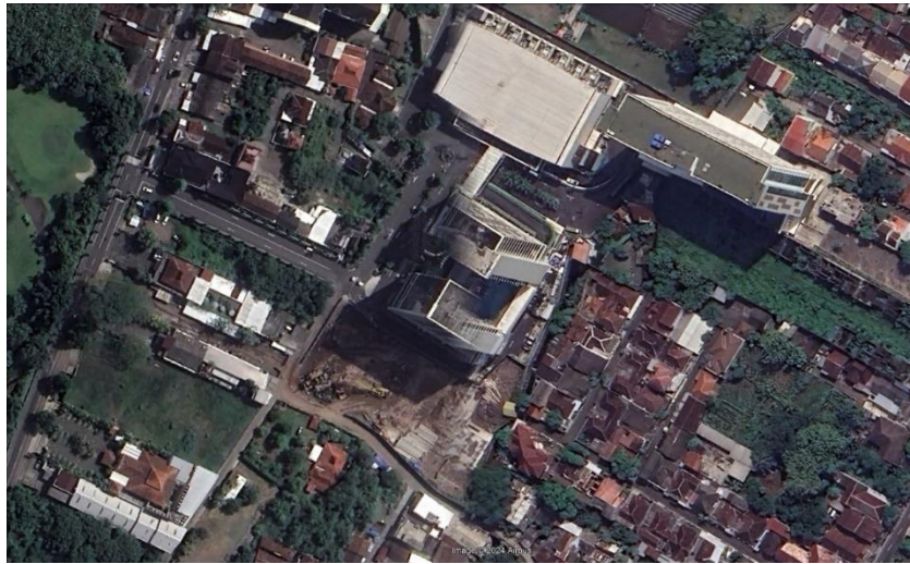
Gambar 5.4 Kondisi Lingkungan Sekitar Tampak Atas
