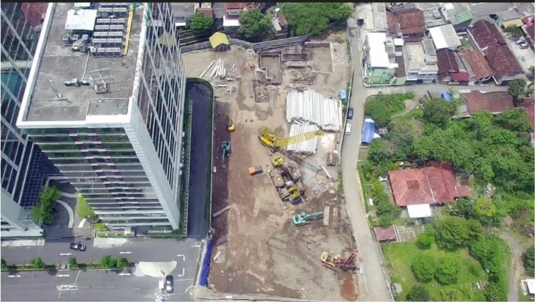
Lampiran 3 Kondisi Lapangan Proyek Tampak Atas
