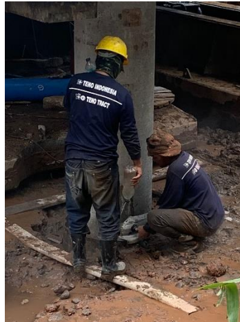
Gambar 5.24 Pemotongan Spun Pile (Lapangan)
