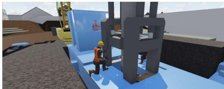
Gambar 5.21 Pengelasan Sambungan Spun Pile (Pemodelan)
