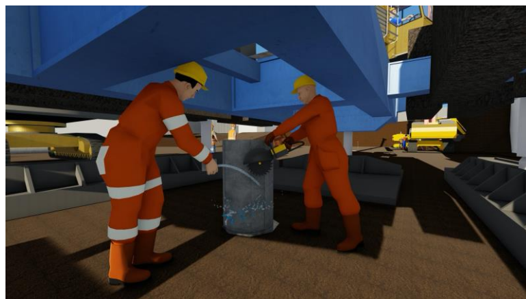
Gambar 5.25 Pemotongan Spun Pile (Pemodelan)
