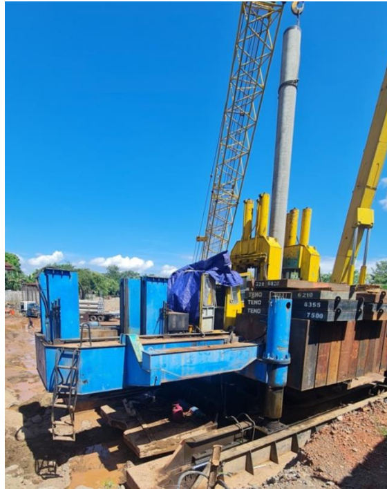
Gambar 5.18 Pengangkatan Spun Pile ke HSPD (Lapangan)
