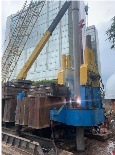
Gambar 5.20 Pengelasan Sambungan Spun Pile (Lapangan)
