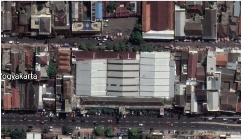
Tampak atas pasar kranggan Sumber : Google Earth
