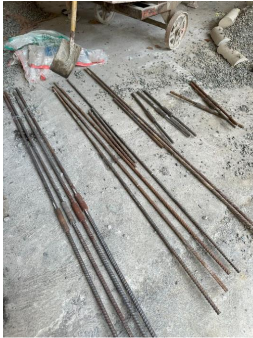
Gambar L-1. 3 Baja Tulangan Sebelum Dirakit
