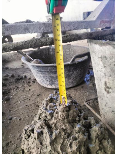
Gambar 5. 11 Uji Slump Pembuatan Benda Uji
