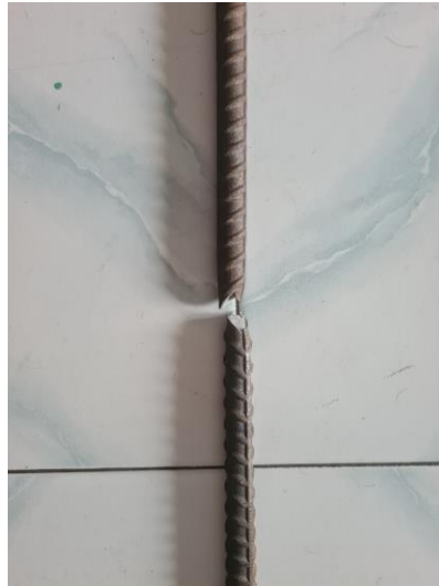
Gambar 5. 5 Baja Tulangan D16 Setelah Pengujian
