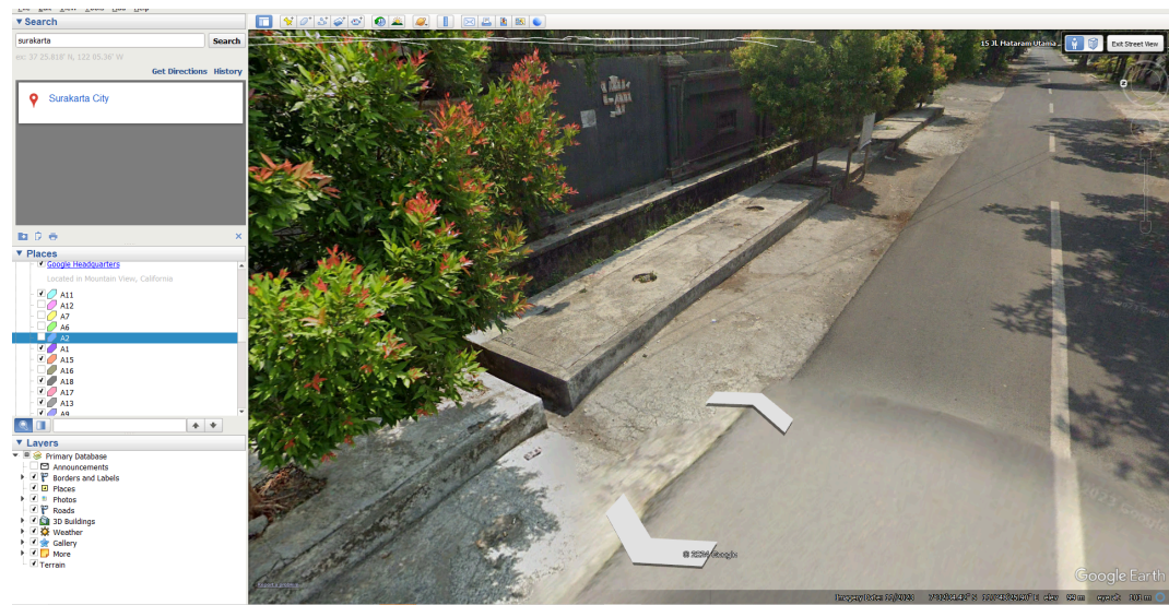
Lampiran 7 Saluran Drainase pada A2
