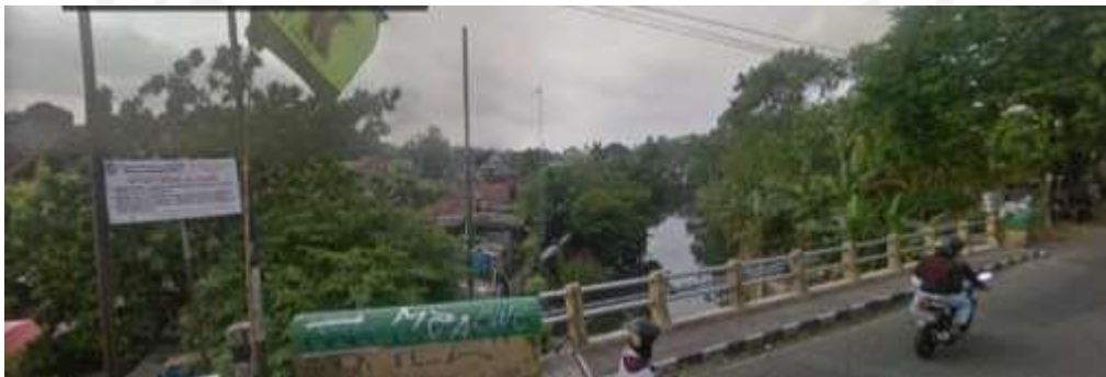
Lampiran 6. Lokasi Pemantauan 6 (Jembatan Kanggotan)
