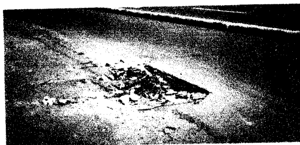
Gambar 4.5 Jenis Kerusakan Ambblas ( Grade Depression )
