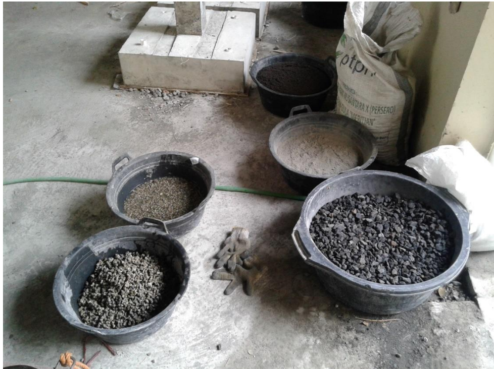
Gambar L.36 Persiapan Material Campuran Beton Sebelum Diaduk
