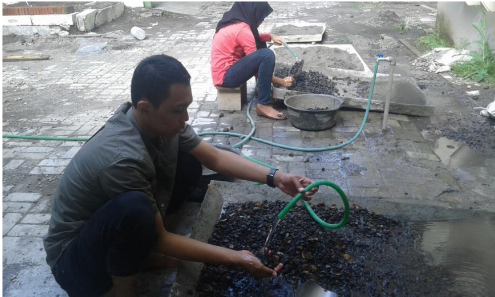
Gambar L.35 Mempersiapkan Bahan Material Dengan Cara Mencuci Agregat Supaya Tidak Ada Pasir/Debu yang Ikut Dalam Campuran Beton
