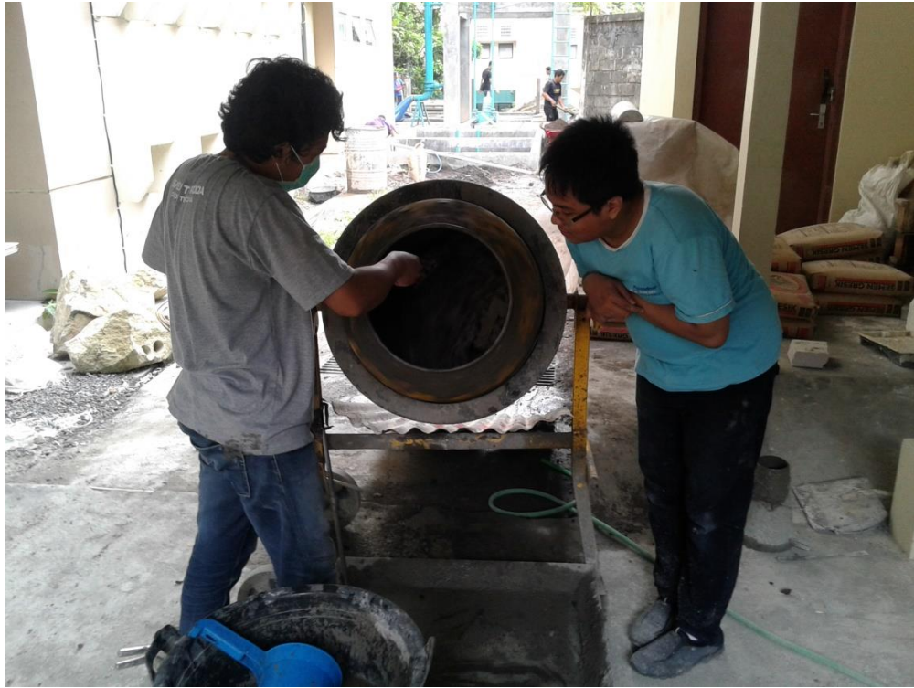
Gambar L.37 Pencampuran Adukan Beton
