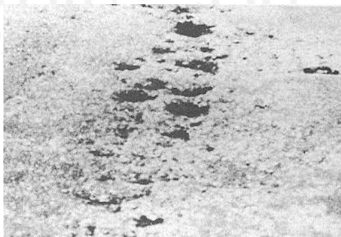
Gambar 3.31 Tingkat High Kerusakan Weathering and Raveling
