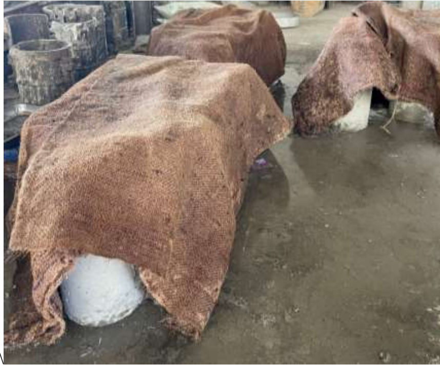
Gambar 4. 2 Perawatan Beton Dengan Metode Penylimutan Karung Goni
