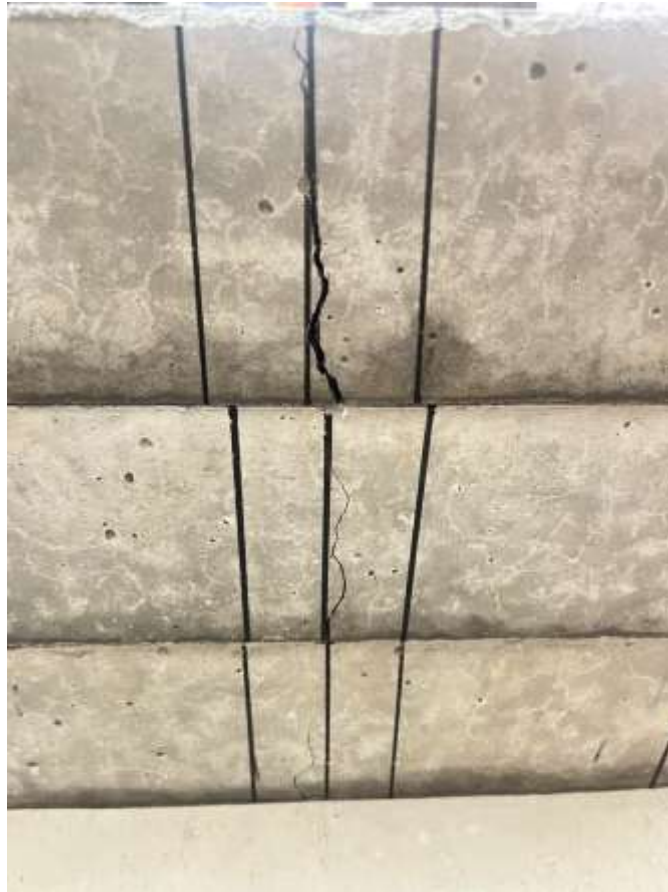
Gambar L-8. 6 Kerusakan benda uji balok setelah pengujian
