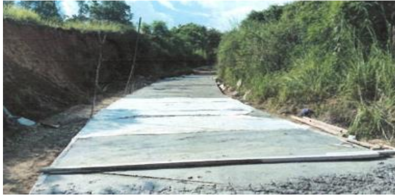
Gambar 5. 4 Kondisi Progres Proyek 75%
