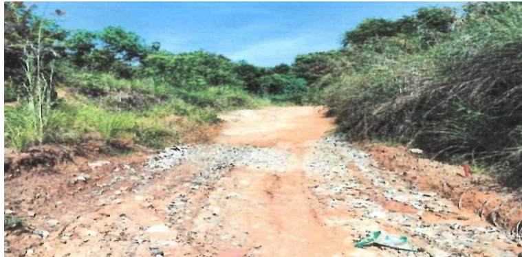
Gambar 5. 1 Kondisi Progres Proyek 0%
