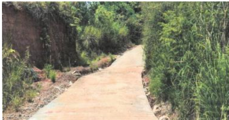
Gambar 5. 5 Kondisi Progres Proyek 100%
