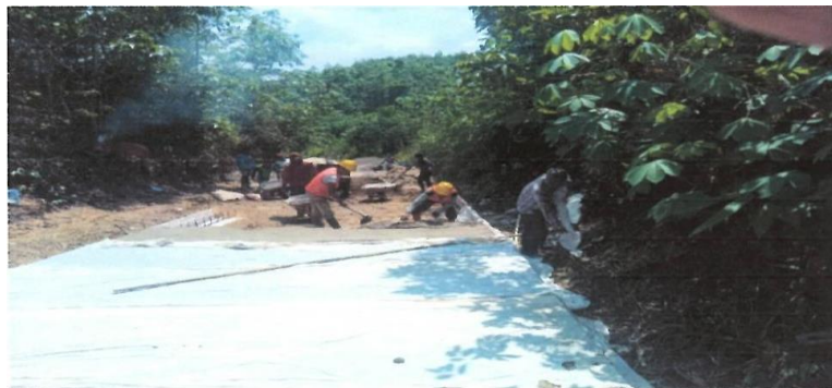
Gambar 5. 2 Kondisi Progres Proyek 25%
