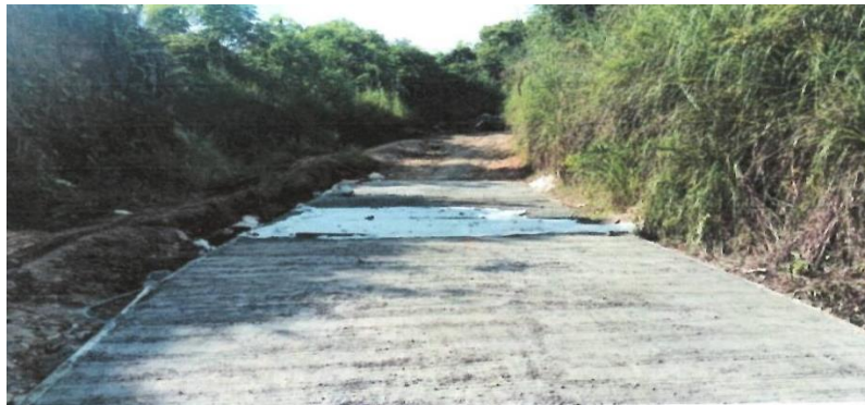
Gambar 5. 3 Kondisi Progres Proyek 50%
