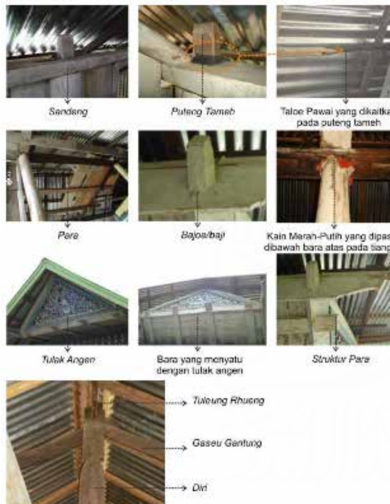
Gambar 2.3.10. Struktur Atap Sumber: Z,Sahputra .,dkk (2020)
