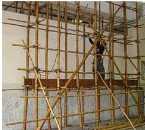
Gambar 3.11 Scaffolding Kayu/Bambu (Sumber: Artiningsih, 2012)
