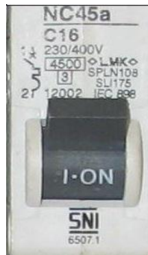
Gambar 2.1 Nameplate MCB pada instalasi rumah.
