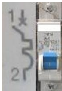
Gambar 2.2 Simbol angka pada MCB.
