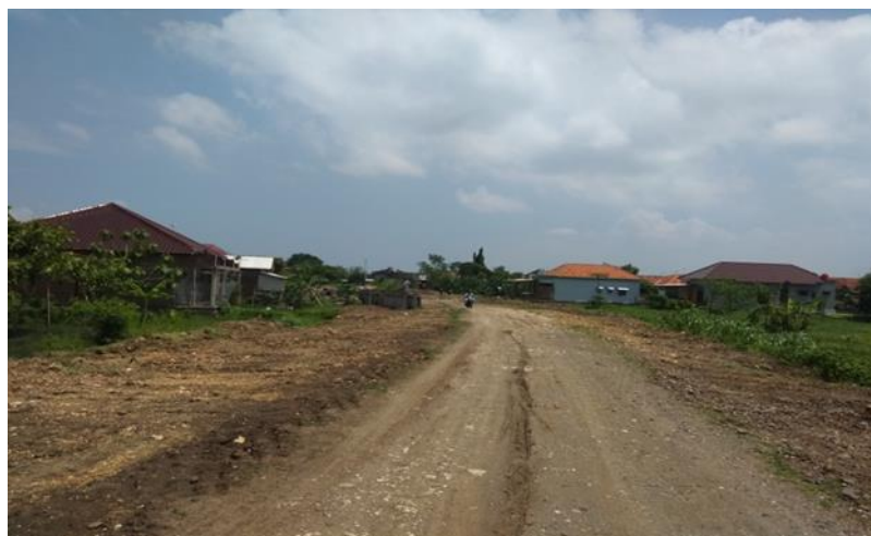
Gambar 3. 2 Kondisi Tanah Setelah Timbunan pada STA 4 + 675
