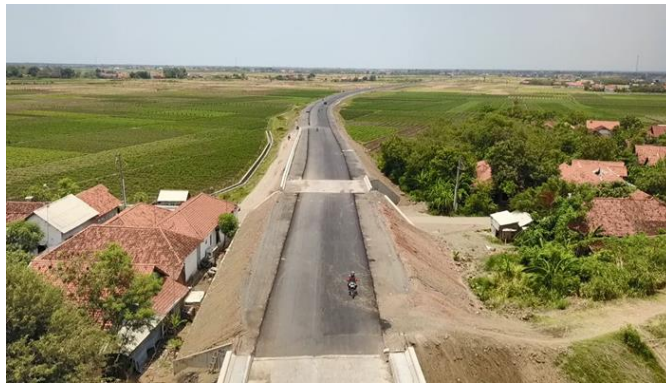
Gambar 1. 2 Tampak Atas Dinding Penahan Tanah pada STA 4+675 – 5+050
