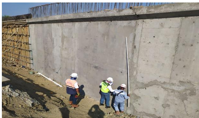
Gambar 3. 12 Dinding Penahan Tanah Pada Proyek
