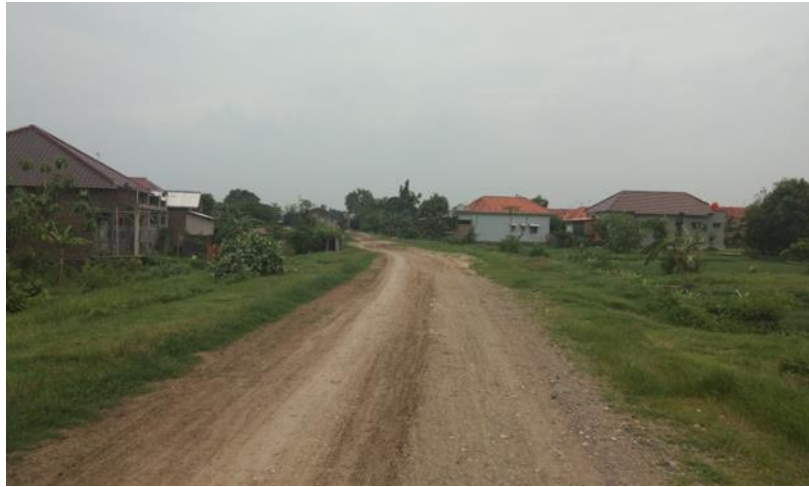
Gambar 3. 1 Keadaan Kondisi Tanah Eksisting pada STA 4 + 675
