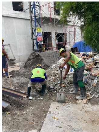
Gambar L-6.9 Pembersihan lokasi proyek agar tidak mengganggu mobilitas pekerja
