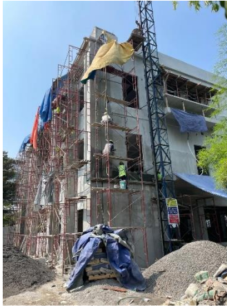
Gambar L- 6.1 Pekerja menggunakan APD ketika Bekerja diKetinggian
