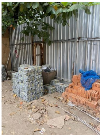
Gambar L-6.6 Penyimpanan material Tertata dengan baik
