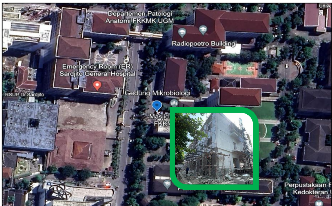
Gambar 5. 1 Lokasi Proyek Pembangunan Gedung Mikrobiologi FKMK UGM
