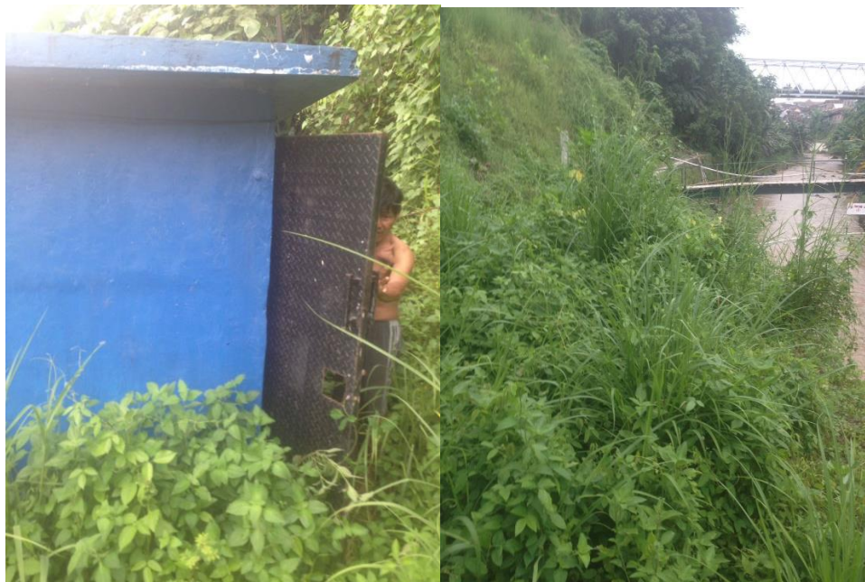
Gambar 4.8 Kondisi Proyek Mata Air 4
