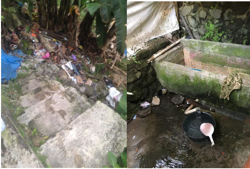
Gambar 4.6 Kondisi Proyek Mata Air 3
