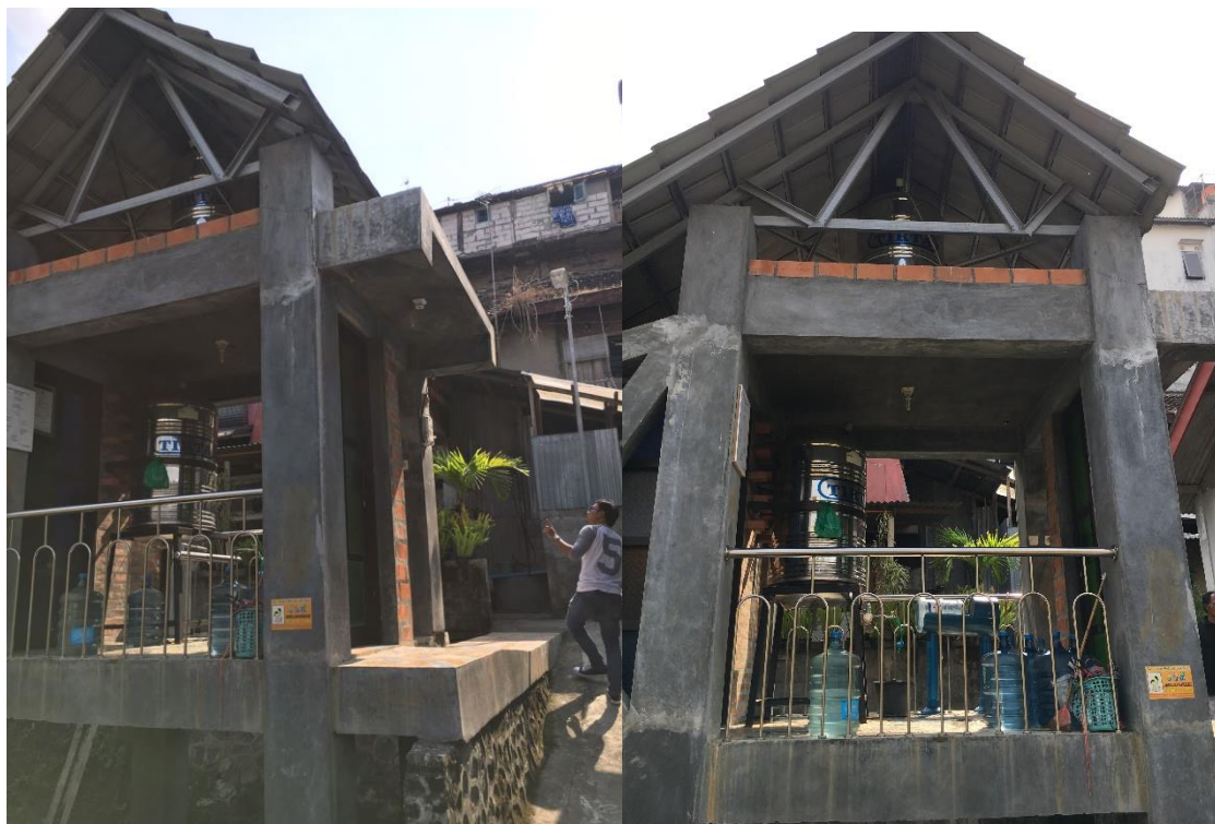
Gambar 4.4 Kondisi Proyek Mata Air 2
