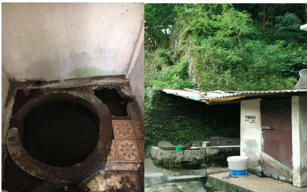
Gambar 4.2 Kondisi Proyek Mata Air 1
