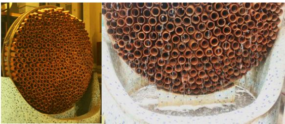
Gambar 2 Instalasi Beehive Cooling System Sumber : Google diakses pada Oktober 2024
