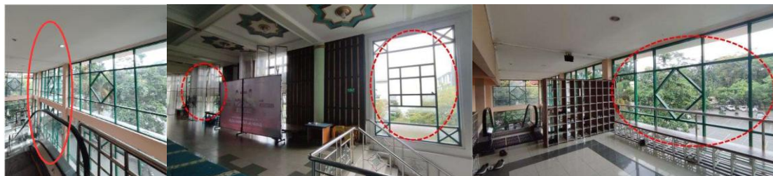
Gambar 6 Area masjid ulil albab yang akan dipasang Instalasi.
