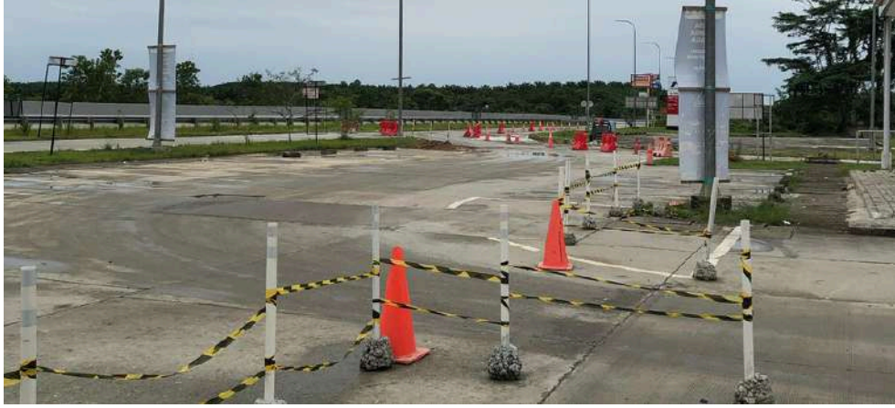
Gambar 1.10 : kondisi eksisting tapak Sumber : Penulis,2025.
