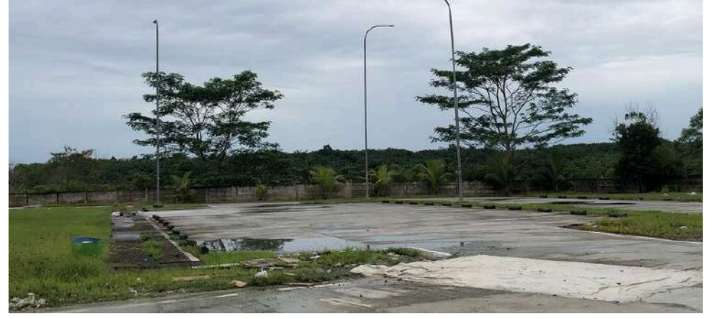
Gambar 1.11 : kondisi eksisting tapak Sumber : Penulis,2025.
