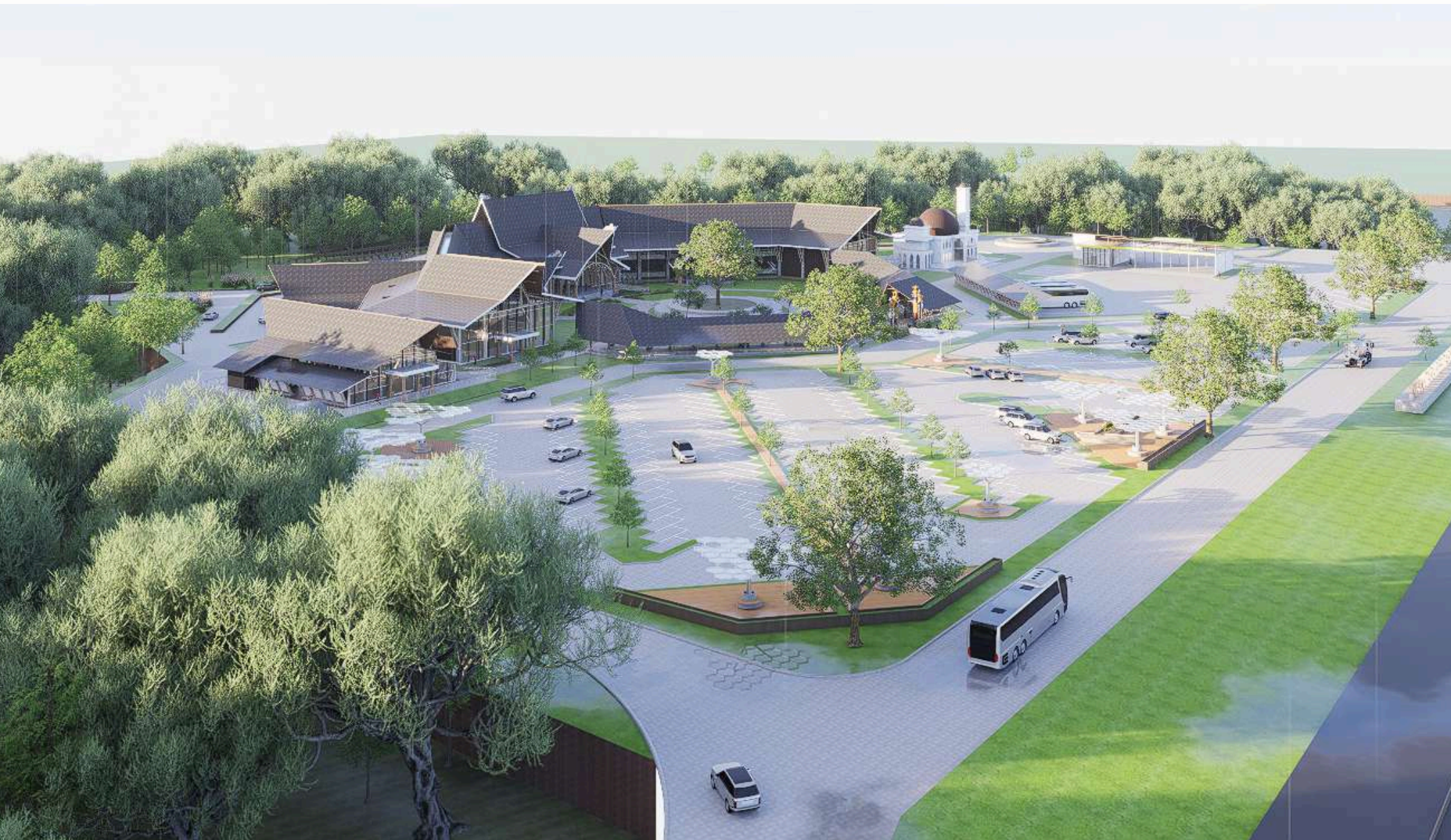
Suasana eksterior bangunan rest area
