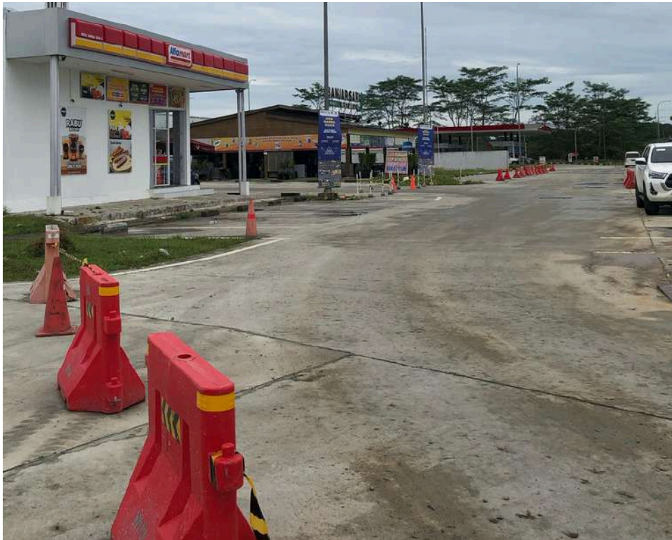
Gambar 1.12 kondisi eksisting tapak Sumber : Penulis,2025.
