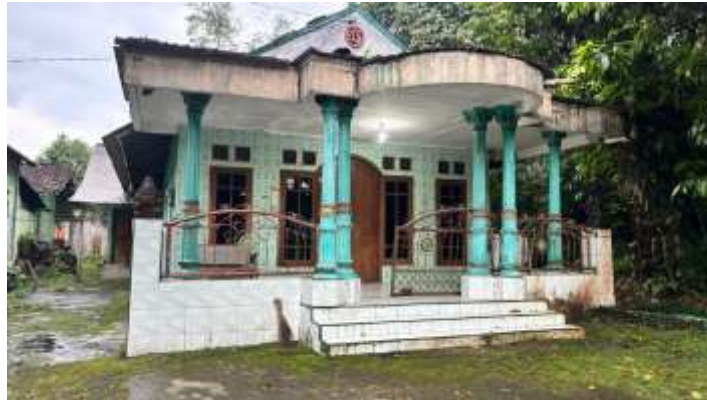
Gambar 5. 5 Kondisi Tata Lingkungan Rumah Tinggal yang Kurang Baik
