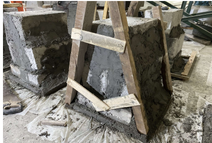
Gambar 4.14 Kayu untuk Panduan Benang Pengukuran
