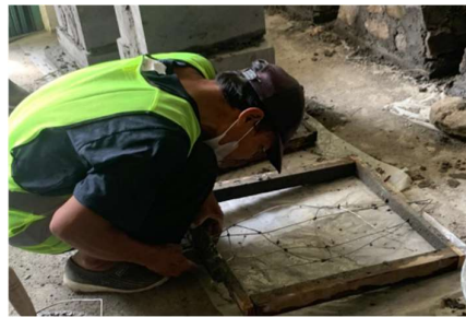
Gambar 4.22 Proses Perakitan antara Cetakan dan Kawat Penguat
