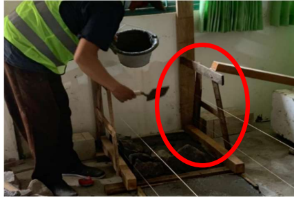
Gambar 4.28 Pengaplikasian Kayu Cetakan Trapesium pada Fondasi Batu Belah
