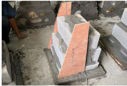
Gambar 4.29 Pengaplikasian Cetakan Trapesium pada Fondasi Blok Beton
