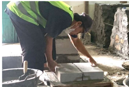
Gambar 4.27 Proses Penyusunan Material Blok Beton pada Sampel
