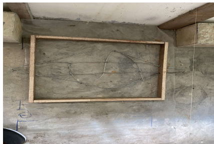
Gambar 4.15 Cetakan Ukuran Dasar Fondasi
