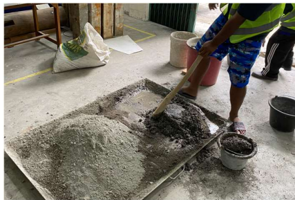
Gambar 4.24 Proses Pembuatan Campuran Plesteran
