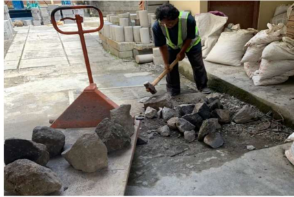
Gambar 4.23 Proses Pemecahan Batu Belah
