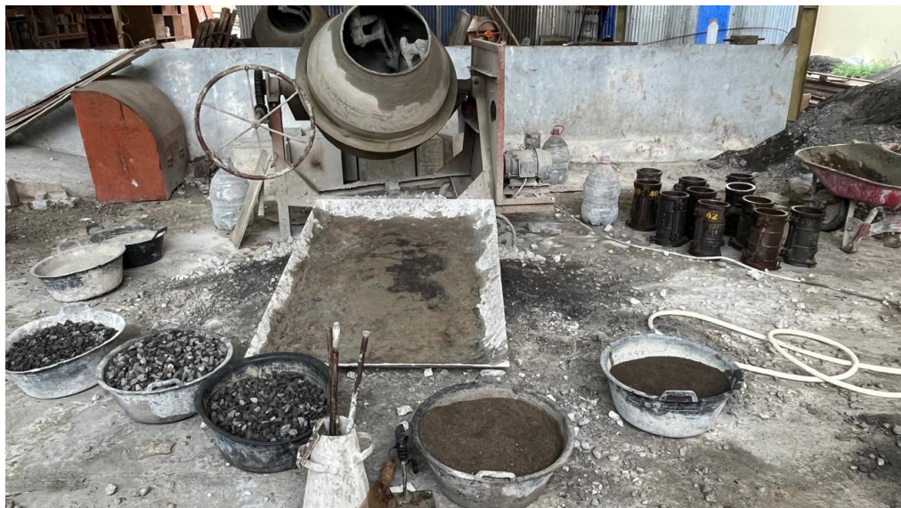
Gambar L-10.4 Persiapan Proses Pembuatan Campuran Beton
