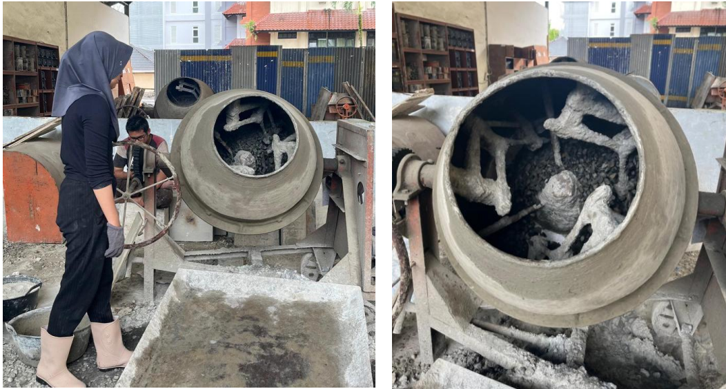
Gambar L-10.5 Proses Pembuatan Campuran Beton (Mixing)
