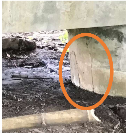
Gambar 1.1 Penambalan pada Tiang Pilar Jembatan Panjang-Pegunungan
