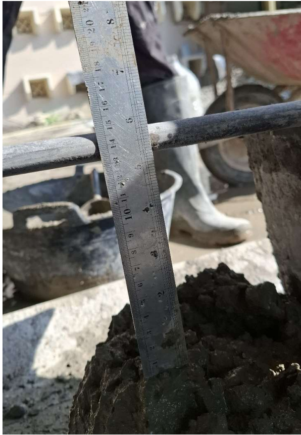
Gambar 5 Uji Slump beton Sebelum di aplikasikan ke Sampel balok
