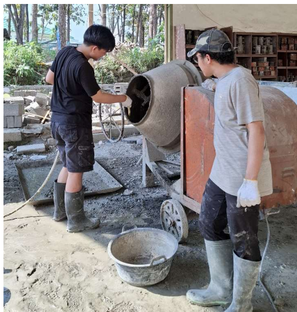
Gambar 4 Pengecoran Sampel Balok
