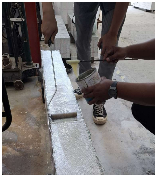
Gambar 4. 5 Pemasangan GFRP pada balok menggunakan roller
