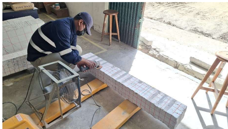
Gambar 4. 3 Pengamplasan permukaan balok sebelum pemasangan GFRP
