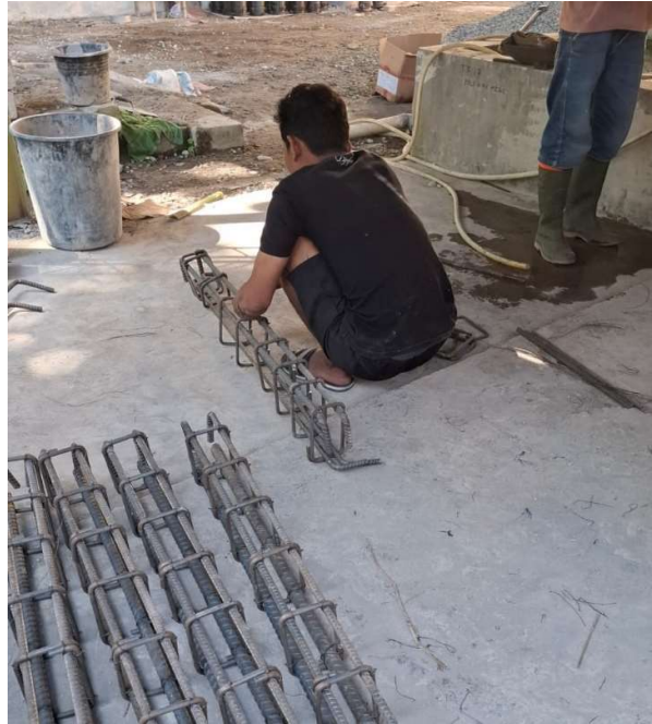
Gambar 7 Perakitan Tulangan untuk Sampel balok
