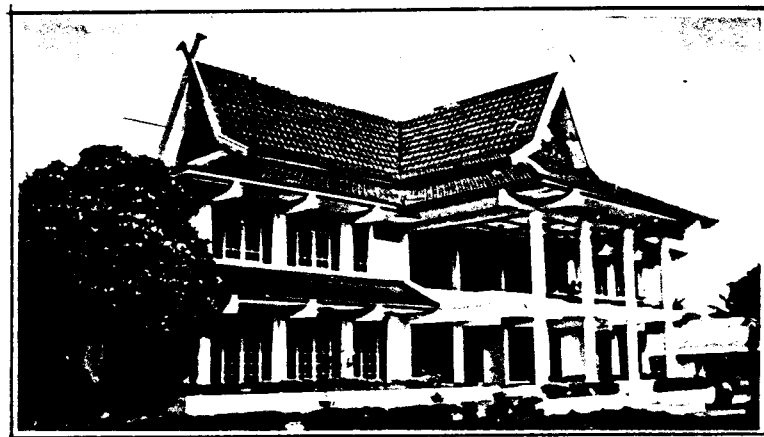
Gamabr 2.4. Bangunan Rektorat, pada Kampus Lama Sumber : Dokumentasi Pribadi
