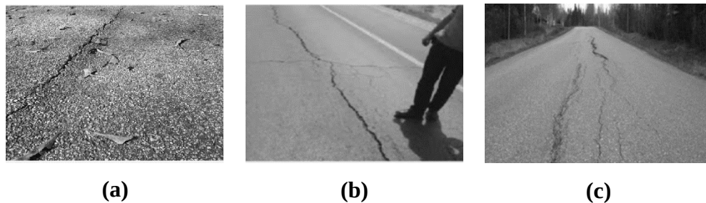
Gambar 3.6 Contoh kerusakan tipe swell (a) low , (b) medium , dan (c) high
