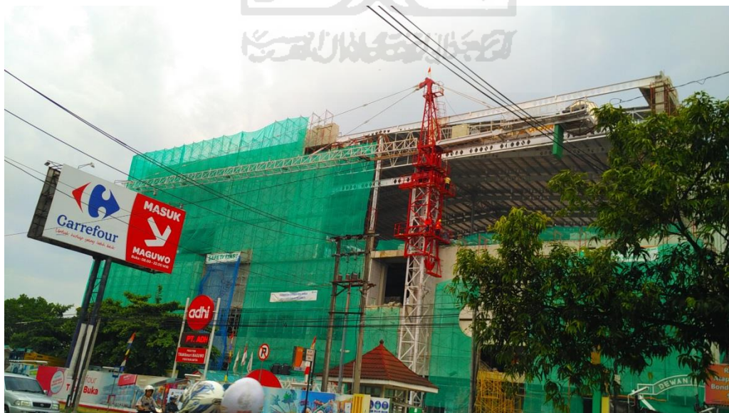
Foto Proyek Pembangunan Transmart Maguwo, Jl. Solo, Yogyakarta
