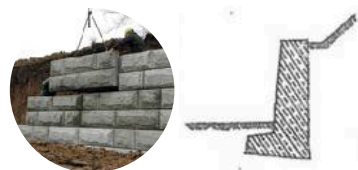
Dinding Penahan Tanah Dari Beton
