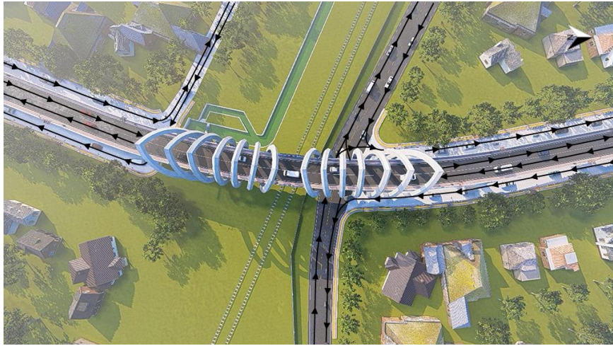
Gambar 5.14 Kondisi Simbang Setelah Pembangunan Flyover
