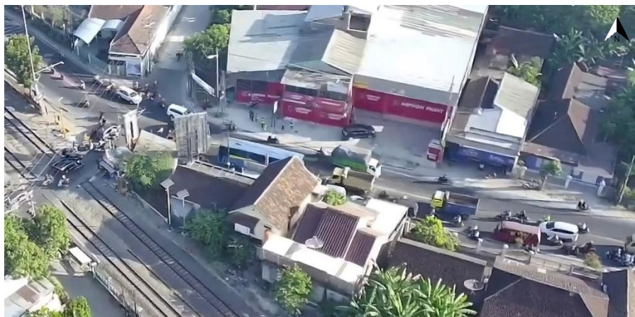
Gambar 1.1 Kondisi Eksisting Tahun 2024 Simpang 4 Proliman
