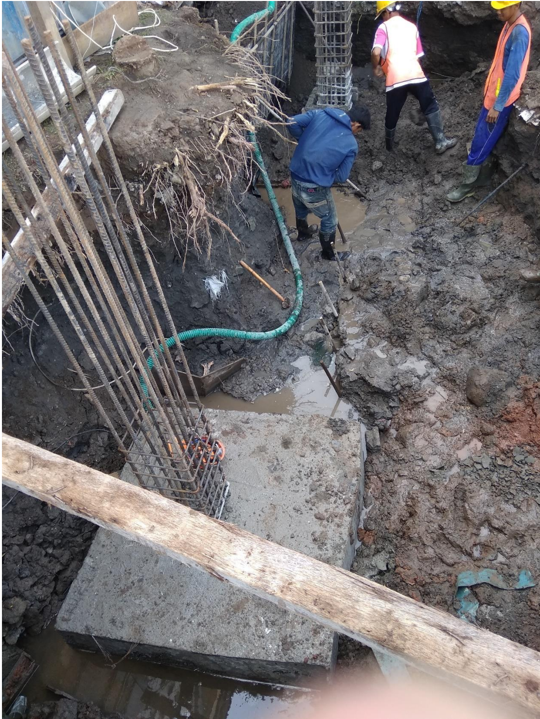
Lampiran 10. Gambar pelaksanaan pekerjaan Pile Cap type PC-6
