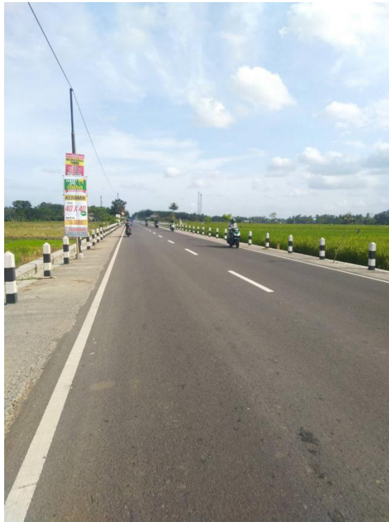
Gambar 1.1 Kondisi Eksisting Jalan
