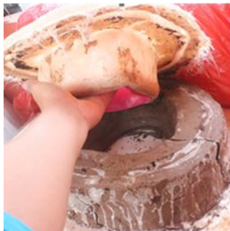
Gambar 3.30 Pelepasan Cetakan Dari Pondasi
