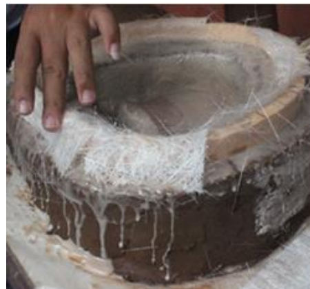
Gambar 3.28 Penambahan Fiberglass dan Pembuatan lis pengunci
