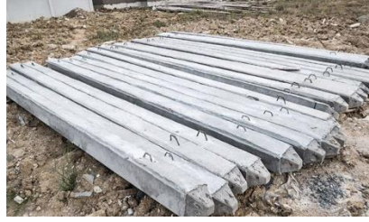
Gambar .Struktur Pondasi Tiang Pancang
