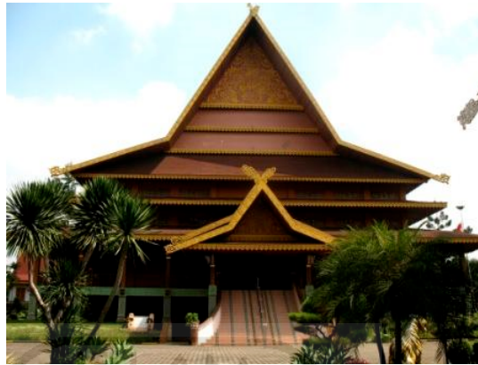
Gambar 2.3 . Bentuk Atap Tebar Layar Sumber : Melayu Online, 2011
