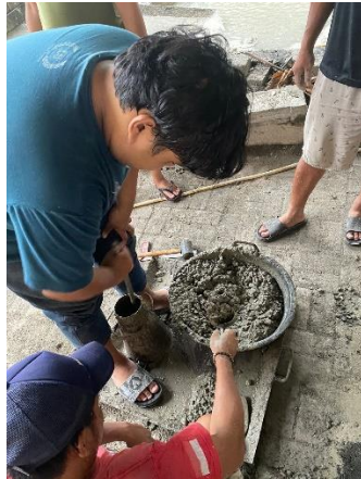
Gambar L. 8.4 Proses Pengujian Slump
