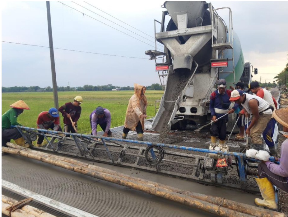
Gambar L-1.3 Kondisi Proyek (Pekerjaan Pengecoran)
