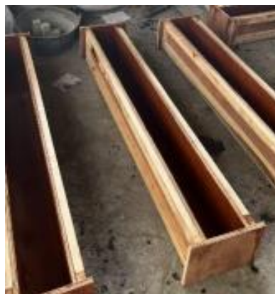
Gambar L-2. 12 Bekisting balok
