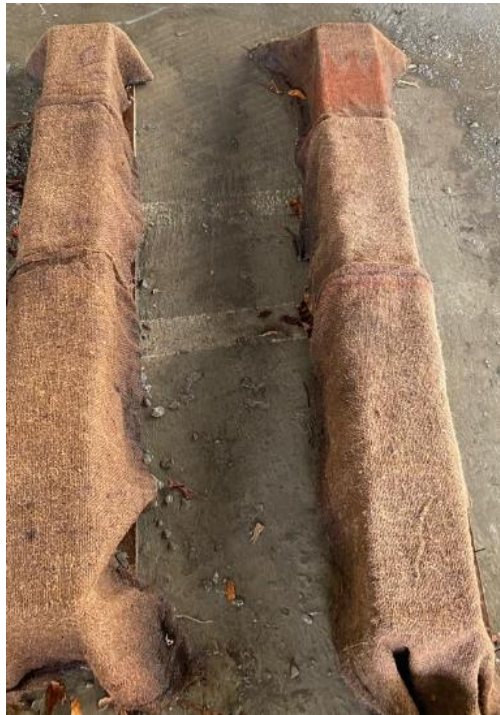
Gambar L-3. 3 Perawatan balok
