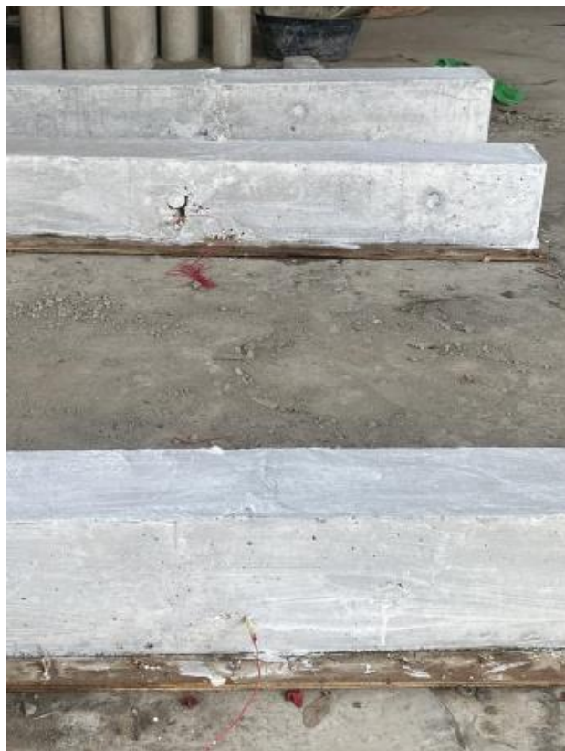
Gambar L-3. 4 Balok di cat
