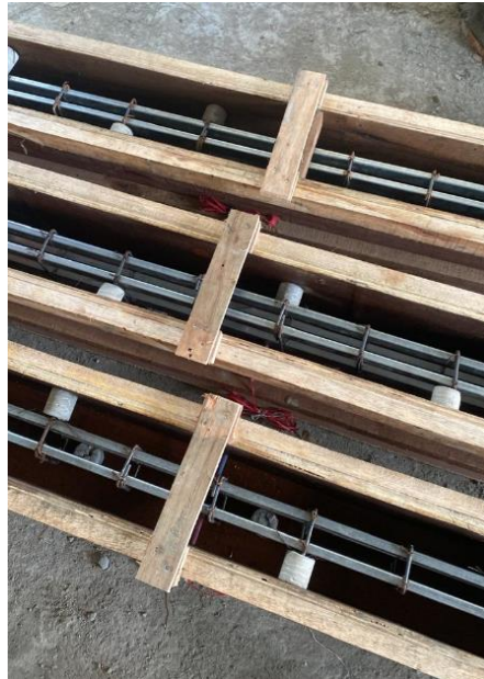
Gambar L-3. 1 Pemasangan tulangan
