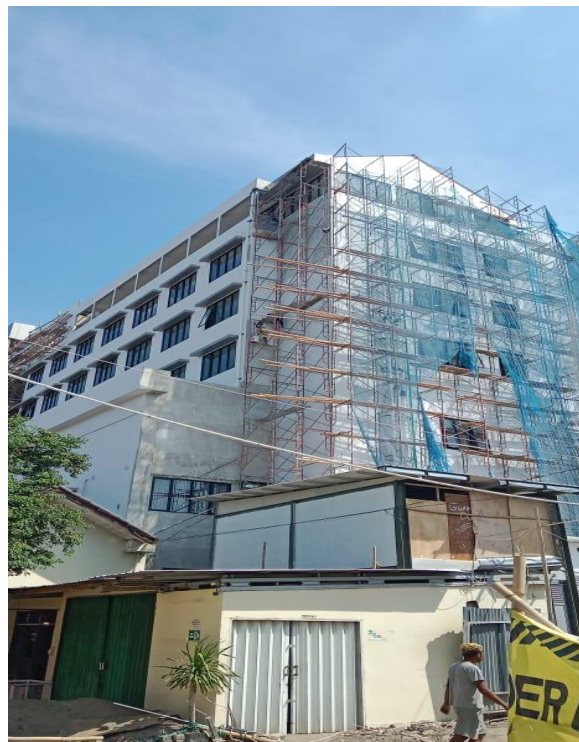
Gambar L-1. 3 Kondisi Proyek Setelah Terpasang Safety Net
