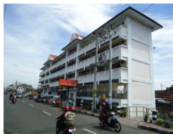
Gambar 2.1.13 Rumah Susun Juminahan
