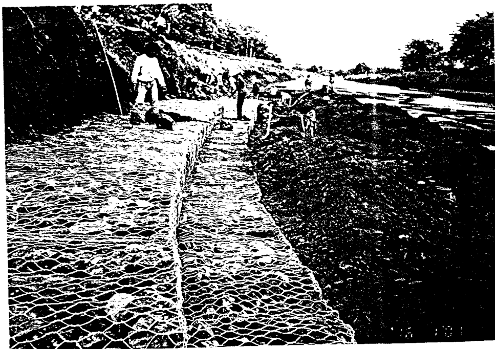
6. HASIL AKHIR PEKERJAAN BRONJONG
