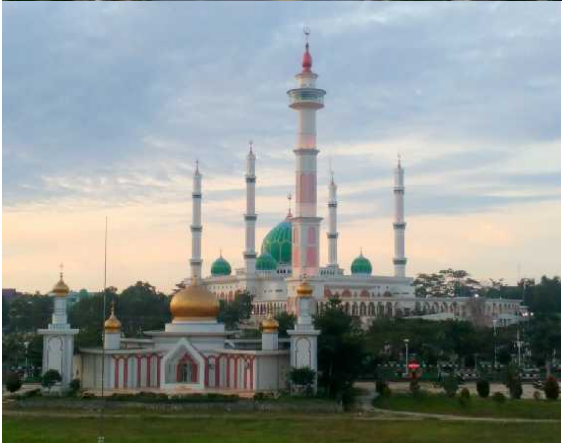
Gambar Masjid Agung Nasional Islamic Centre Pasir Pengaraian
