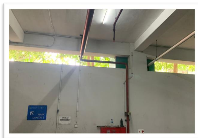
Gambar 4.5 Kondisi eksisting ventilasi alami
