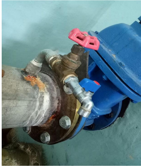
Gambar 4.7 Keran kontrol pada IPA Mata Air Clereng (Sumber : Dokumentasi, 2018)
