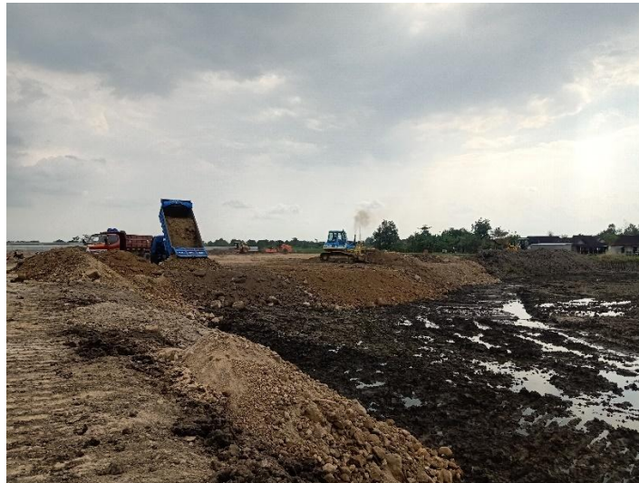
Gambar 1.1 Pekerjaan Timbunan Proyek Jalan Tol
