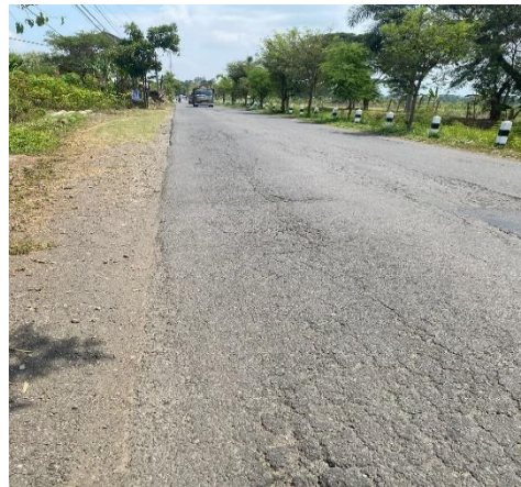
Gambar 1. 3 Kerusakan retak pada Ruas Jalan Klangon-Tempel
