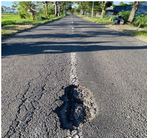
Gambar 1. 3 Kerusakan retak pada Ruas Jalan Klangon-Tempel
