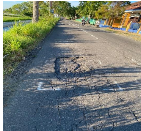
Gambar 1. 2 Kerusakan Permukaan Jalan Berupa lubang
