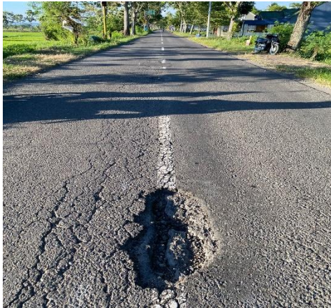
Gambar 1. 2 Kerusakan Permukaan Jalan Berupa lubang
