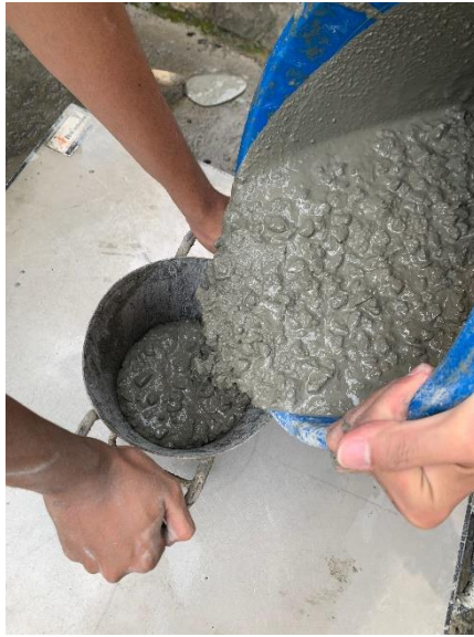
Gambar Lampiran 8.5 Proses Penuangan Beton
