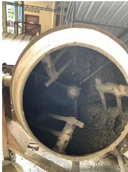
Gambar Lampiran 8.4 Proses Pencampuran Beton
