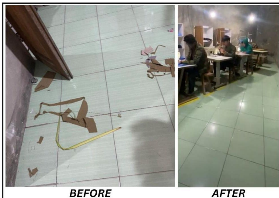
Gambar 4. 19 Setelah Dilakukan Perbaikan
