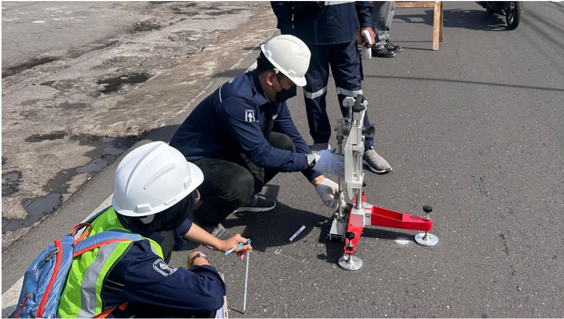
Gambar 9 Pengujian BPT STA 8+700 Kondisi Kering
