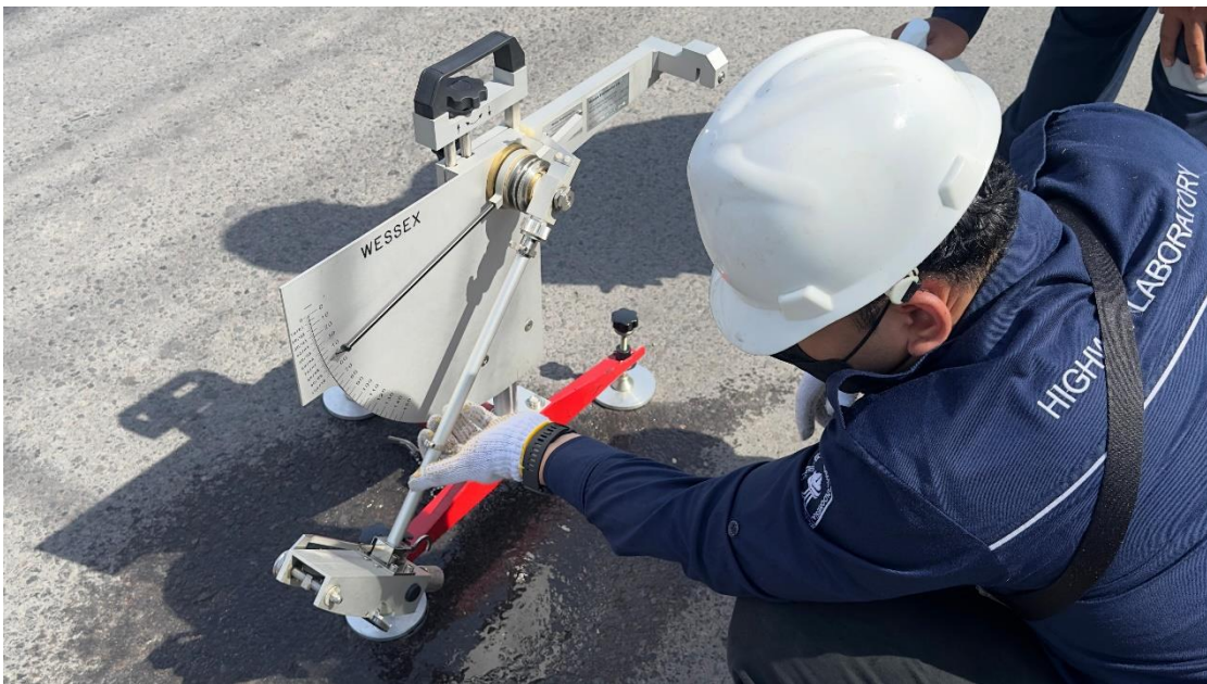
Gambar 18 Pengujian BPT STA 8+500 Kondisi Basah
