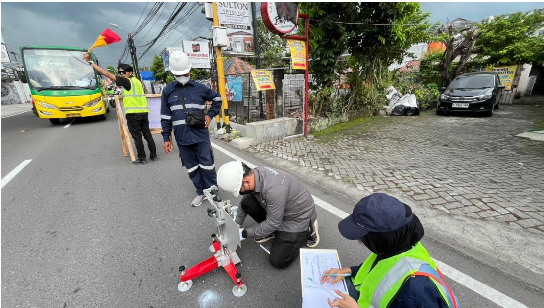
Gambar 10 Pengujian BPT STA 8+900 Kondisi Kering
