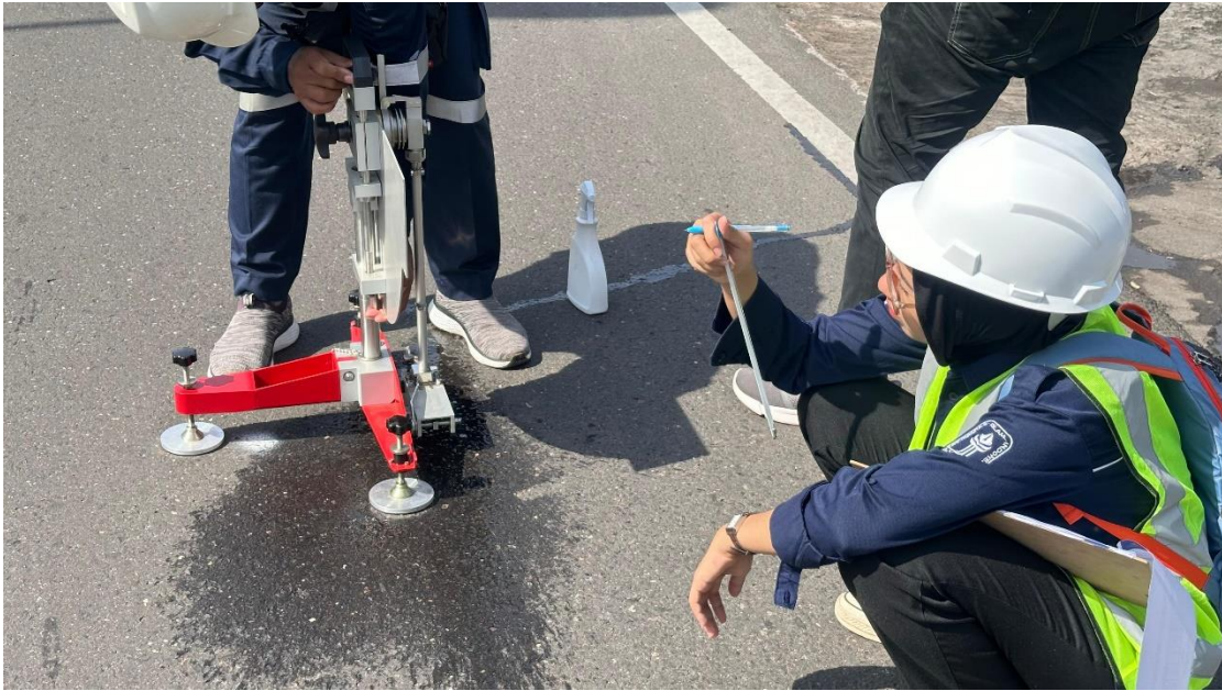
Gambar 17 Pengujian BPT STA 8+300 Kondisi Basah
