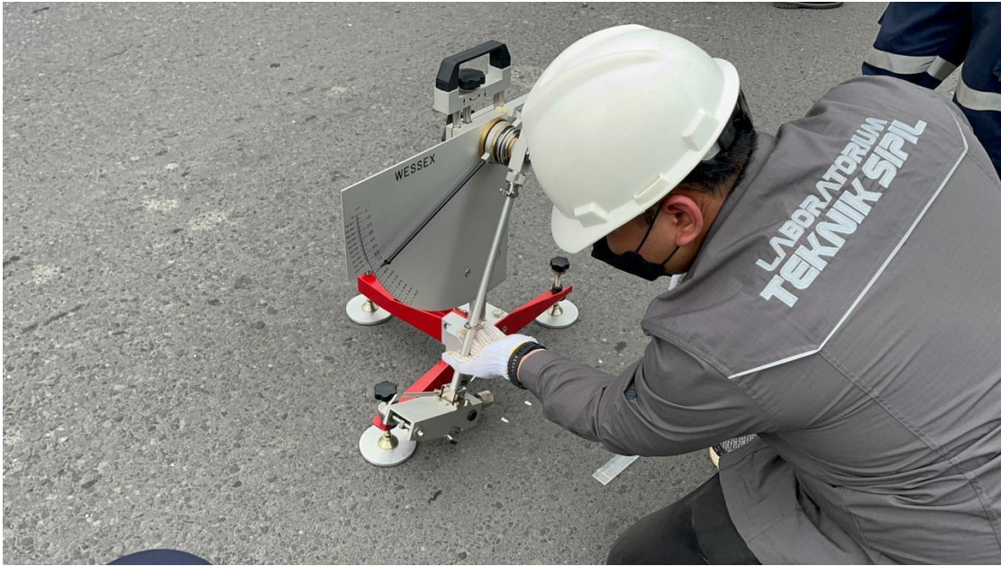
Gambar 7 Pengujian BPT STA 8+300 Kondisi Kering
