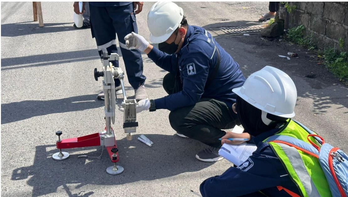
Gambar 2 Pengujian BPT STA 8+200 Kondisi Kering
