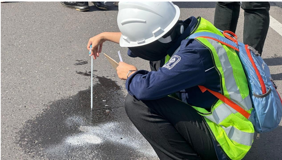
Gambar 14 Pengujian BPT STA 8+600 Kondisi Basah
