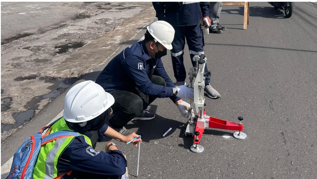
Gambar 6 Pengujian BPT STA 8+100 Kondisi Kering
