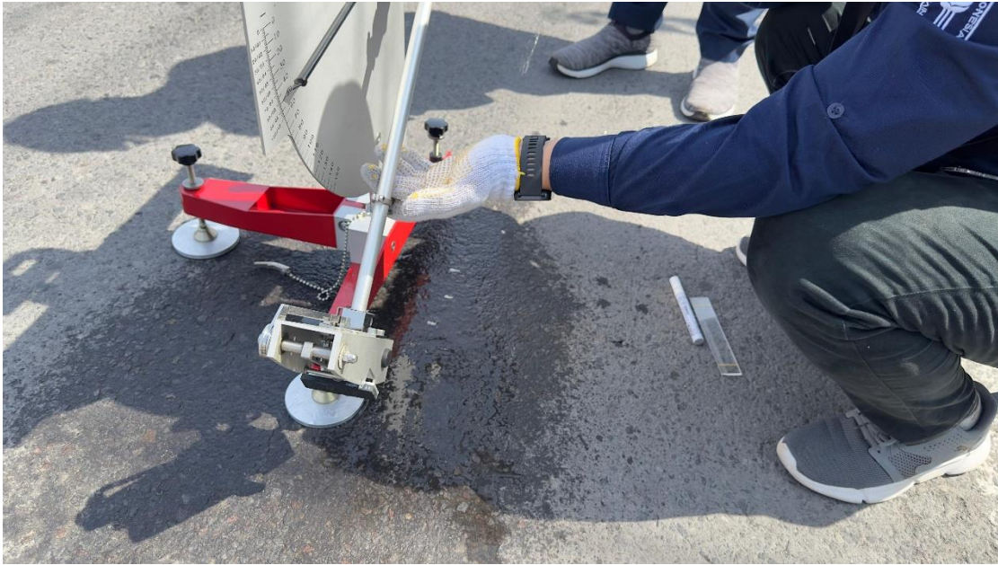
Gambar 15 Pengujian BPT STA 8+800 Kondisi Basah
