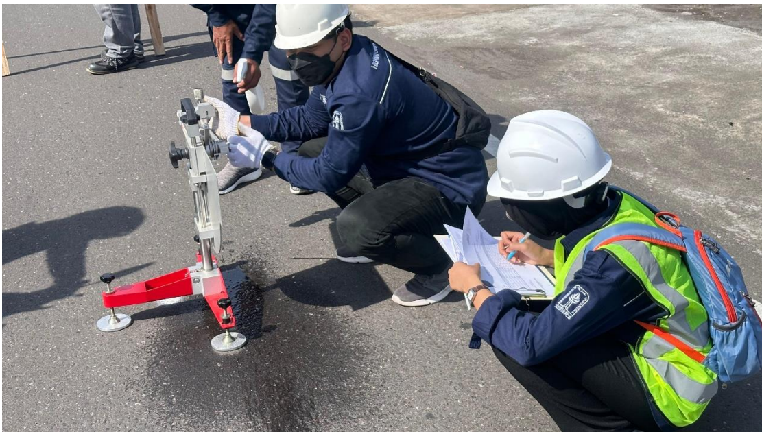
Gambar 20 Pengujian BPT STA 8+900 Kondisi Basah
