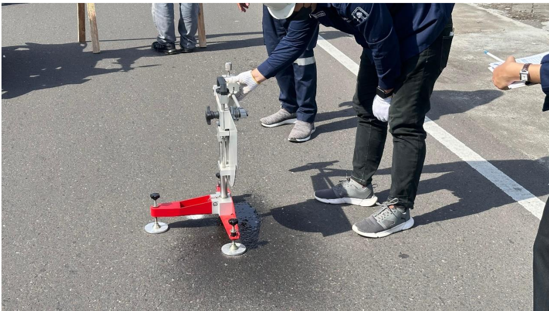
Gambar 16 Pengujian BPT STA 8+100 Kondisi Basah
