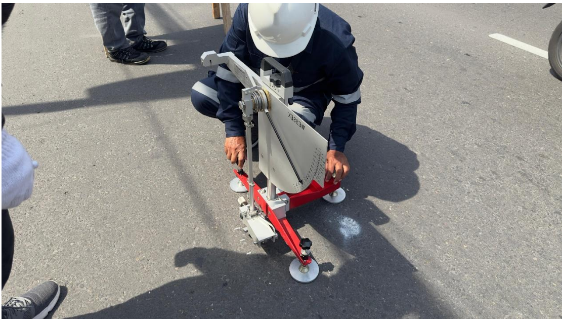
Gambar 8 Pengujian BPT STA 8+500 Kondisi Kering
