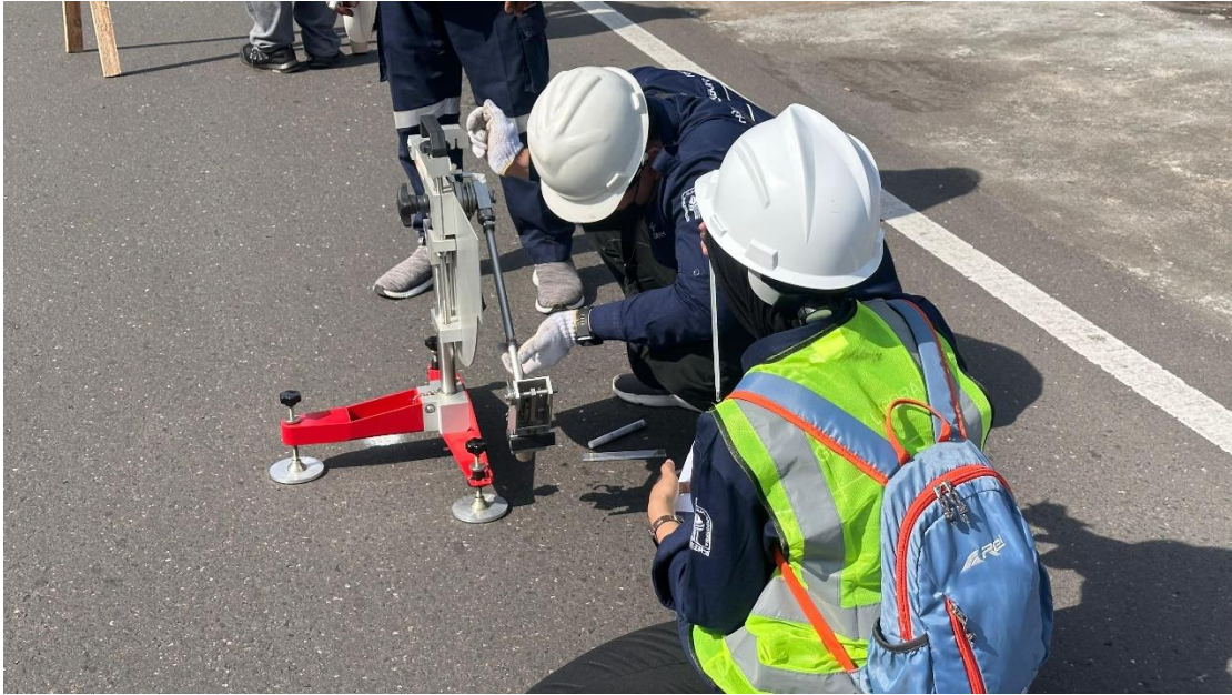
Gambar 1 Pengujian BPT STA 8+000 Kondisi Kering
