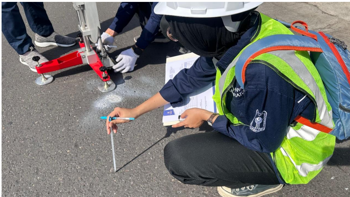
Gambar 4 Pengujian BPT STA 8+600 Kondisi Kering
